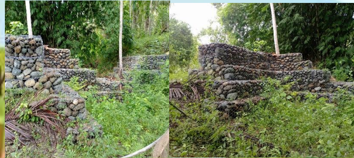
Pembuatan Dam Penahan di Desa Pongian Kec. Bunta
